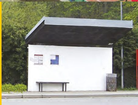
Autobusové zastávky Realizace: 2013 Dotace: 445 023 Kč Dotace: MAS Říčnsko
